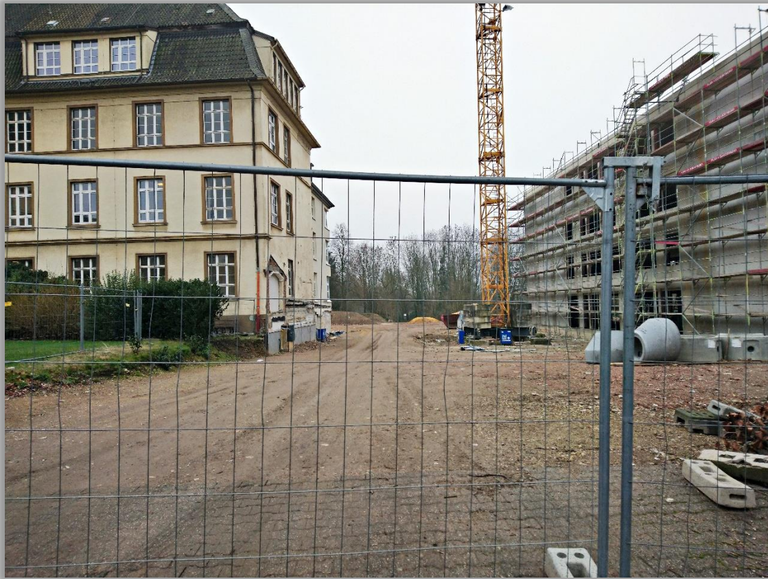
Abbildung 11 Standort des ehem. Gründungsgebäudes ( wie Abb. 11) nach dem Abriss mit Rohbau der künftigen Pflegeschule (Foto © Kohlengräberland 2/2023)
