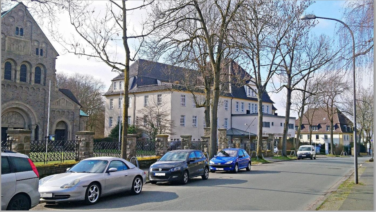
Abbildung 9 St. Maria-Hilf-Krankenhaus in Bochum-Gerthe 2022 vor dem Abriss des Gründungsgebäudes (Foto © Kohlengräberland)
