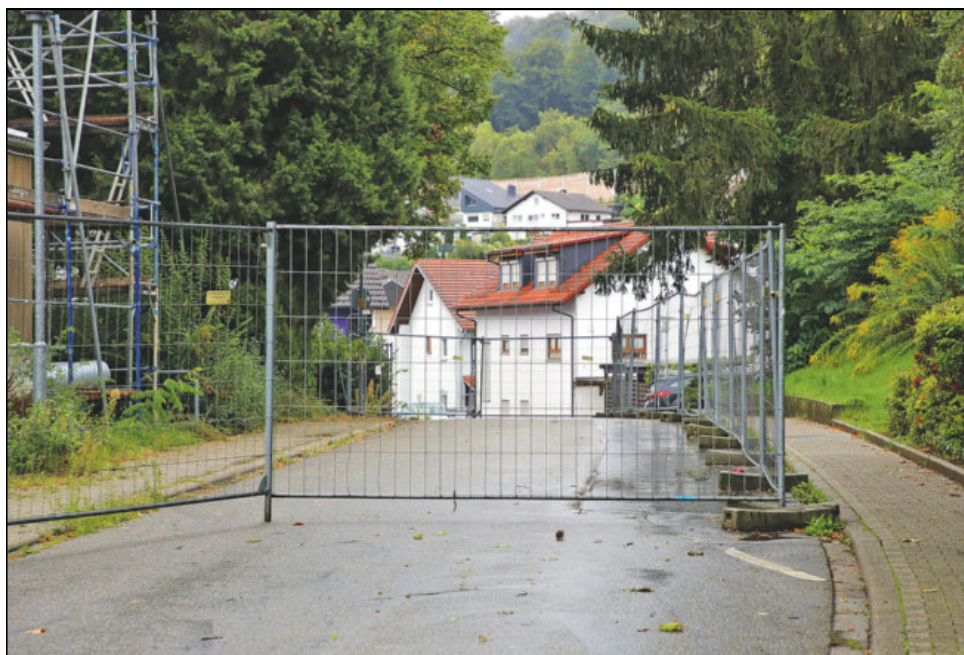
Ein Bauzaun versperrt derzeit die Durchfahrt durch die Pestalozzistraße, die zwischen Schulgebäude (links) und Leimbachhalle hindurchführt. Foto: Helmut Pfeifer
