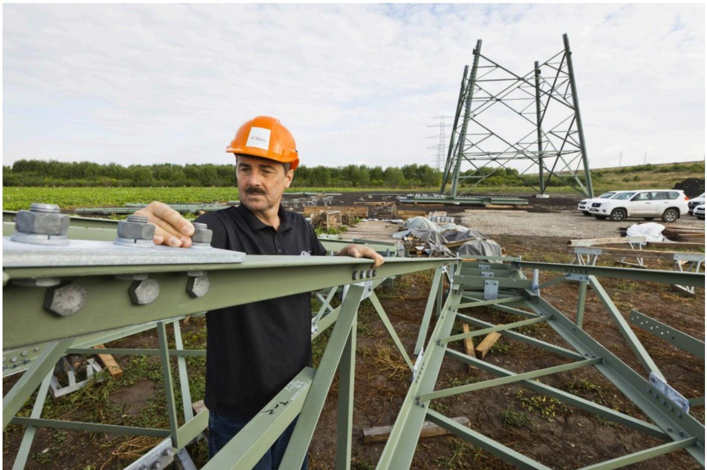
*Baukontrolleur überprüft Schraubverbindungen an Segmenten für Höchstspannungsmasten an einer im Bau befindlichen 380-kV-Höchstspannungsleitung bei Wipfratal in Thüringen. Wie laut die fertigen Trassen im Betrieb nachher werden, hängt sowohl von der verwendeten Technik (Gleich- oder Wechselstrom) als auch von der Witterung und den genutzten Leiterseilen ab. Foto: imago/imagebroker*
