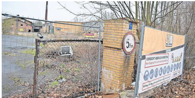
Seit Jahren wurde der Abriss auf dem Gelände der ehemaligen Keramischen Hütte angekündigt – passiert ist bislang nichts. FOTO: ACHIM GÜCKEL (ARCHIV)
