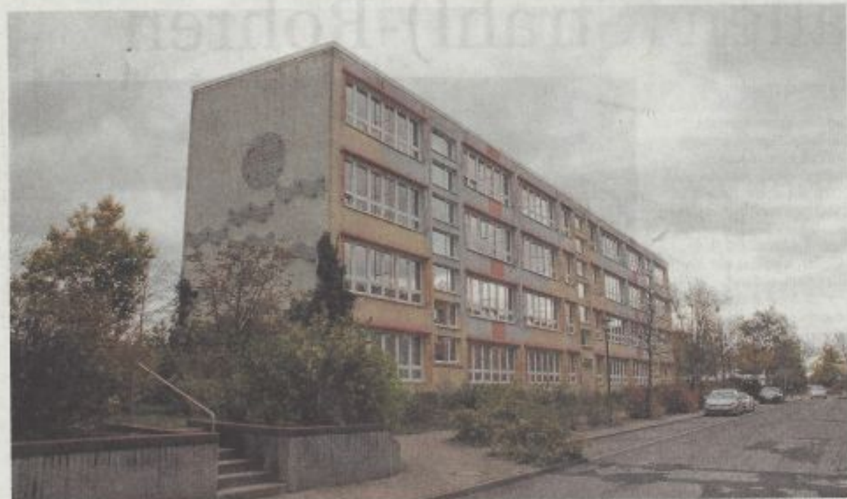
Die Raumgröße in der Kollwitz-Grundschule entspricht nicht mehr den gesetzlichen Erfordernissen. Aber vor allem beim Brandschutz liegt einiges im Argen. Aufgrund der Anordnung der Klassenzimmer sind die Fluchtwege längst nicht mehr zeitgemäß. FOTO: ANDREAS SEGETH
