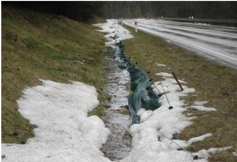
Von der Schneeräumung zerstörter Amphibienzaun im April 2008
