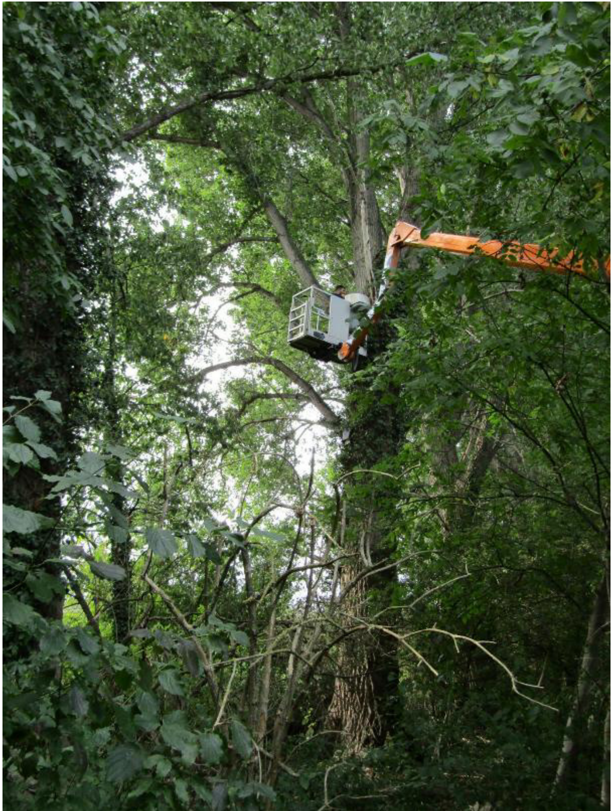
Foto 11: Hubsteiger an einer der Pappeln; Bohren einer Baumhöhle; 21.8.2025
