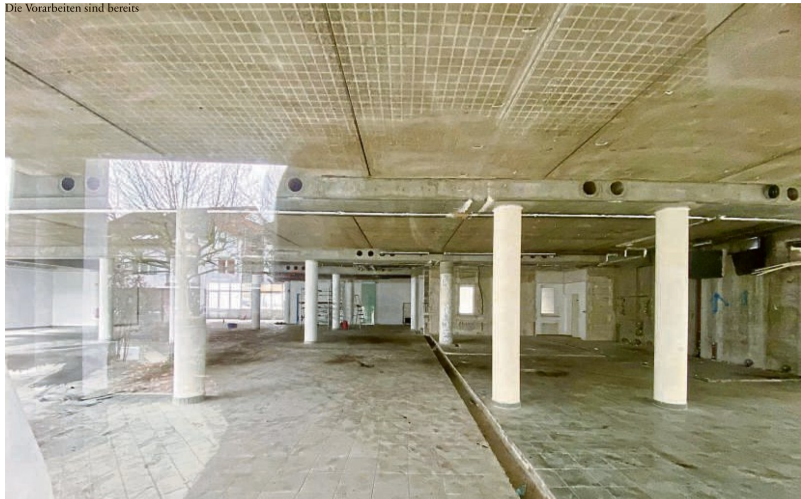
Zweiter Umbau-Akt: Das Innere wird für die neue Bibliothek umgemodelt. Die Vorarbeiten sind erledigt, der Rest folgt.
