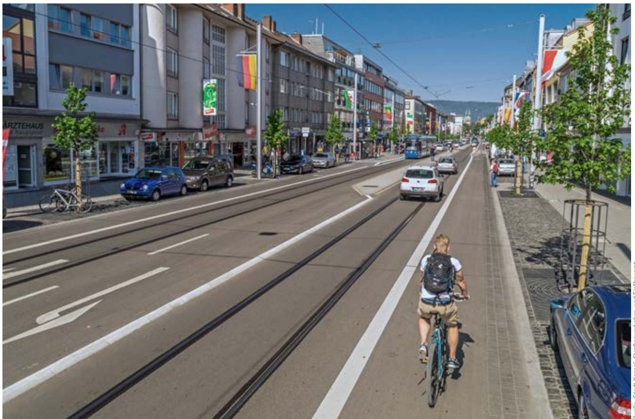
Durch eine effiziente Aufteilung der Verkehrsflächen konnten ein durchgängiger Radfahrstreifen sowie – auf weiten Teilen – auch ein als Querungshilfe dienender Mittelstreifen errichtet werden.
