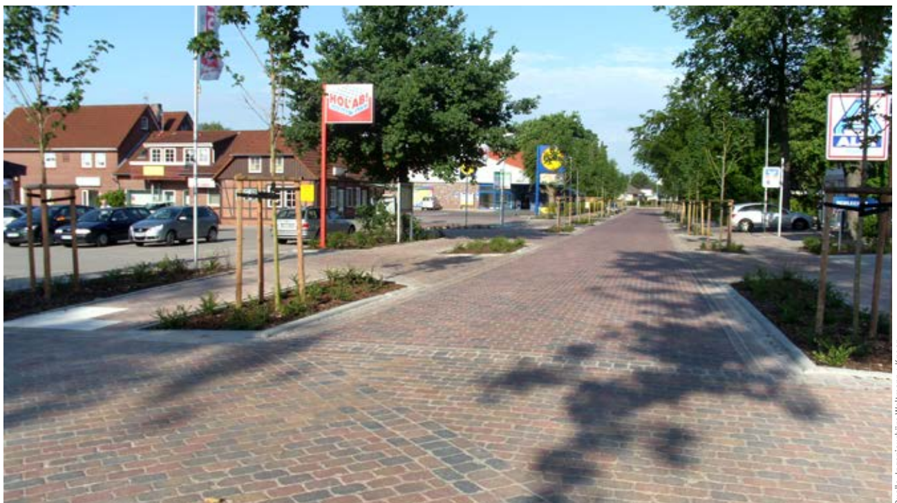
Die Zufahrten zu den Parkflächen der Einzelhändler wurden in die Straßengestaltung integriert.
