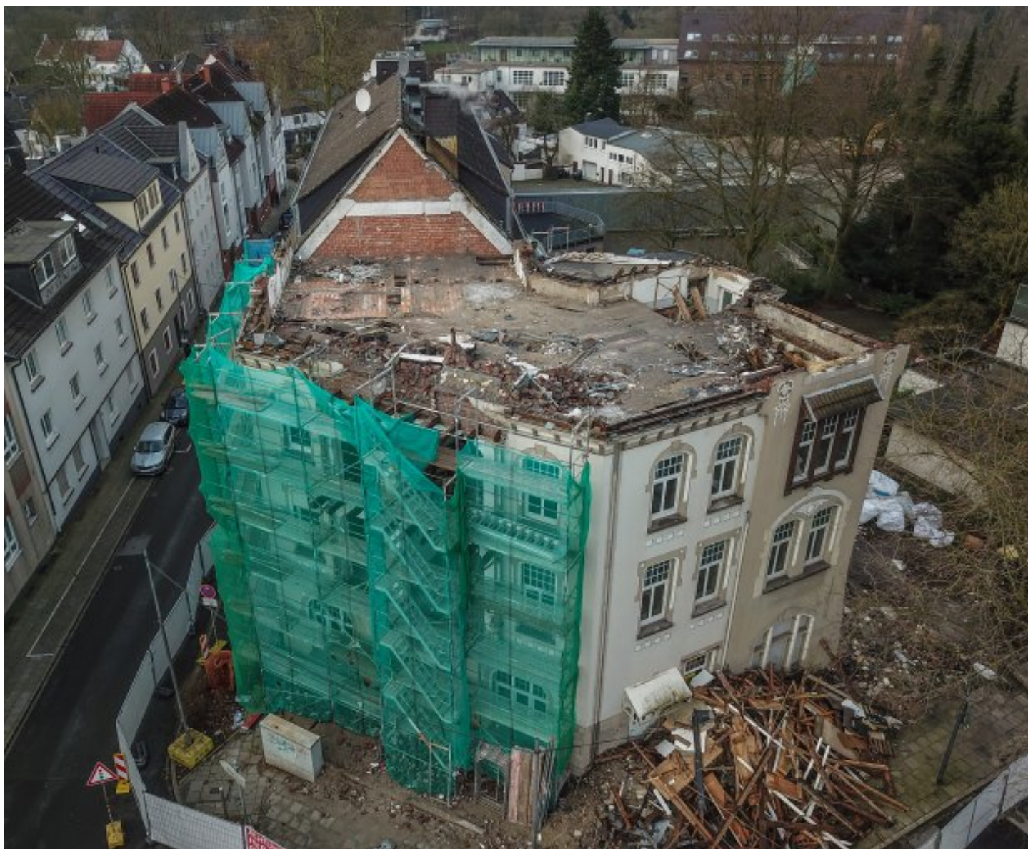
Eine Multicopter-Aufnahmen vom Abriss des Kaiser-Friedrich-Hauses. Das Foto wurde Anfang Februar 2018 aufgenommen. Foto: Michael Gohl / FUNKE Foto Services
