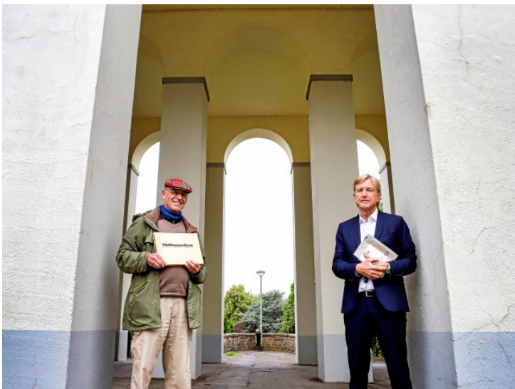
Johannes von Geymüller (l.) und Gerd-Ulrich Kapteina, beide vom Arbeitskreis Essen 2030, setzen sich für den Erhalt der Häuserzeile an der Angerstraße und damit für den Fortbestand des kompletten Ensembles Eyhof-Siedlung ein. Foto: Julia Tillmann / FFS
