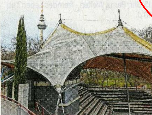
Das verschmutzte und oft geflickte Dach wird erneuert.
