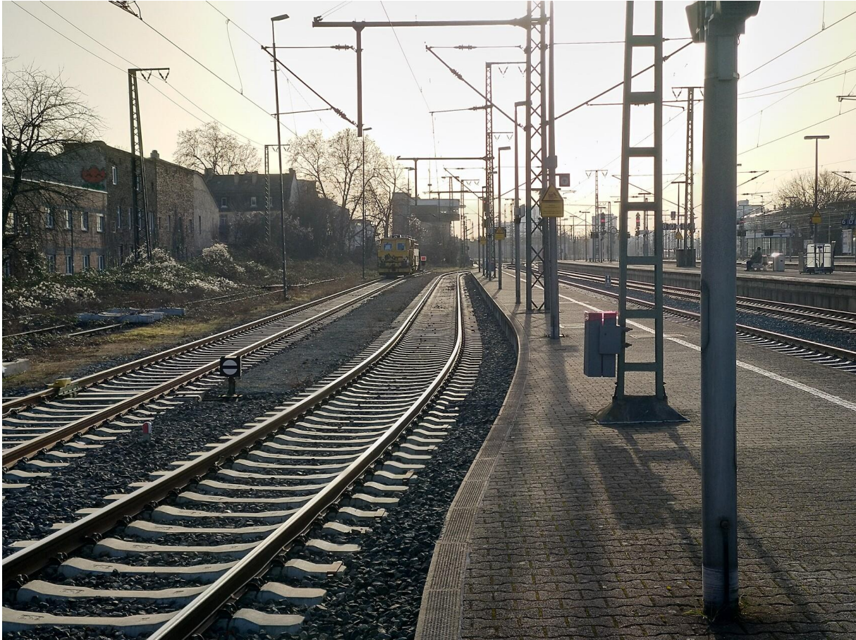
Abbildung 3: Intaktes Abstellgleis und weiter links stillgelegte Abstellgleise
