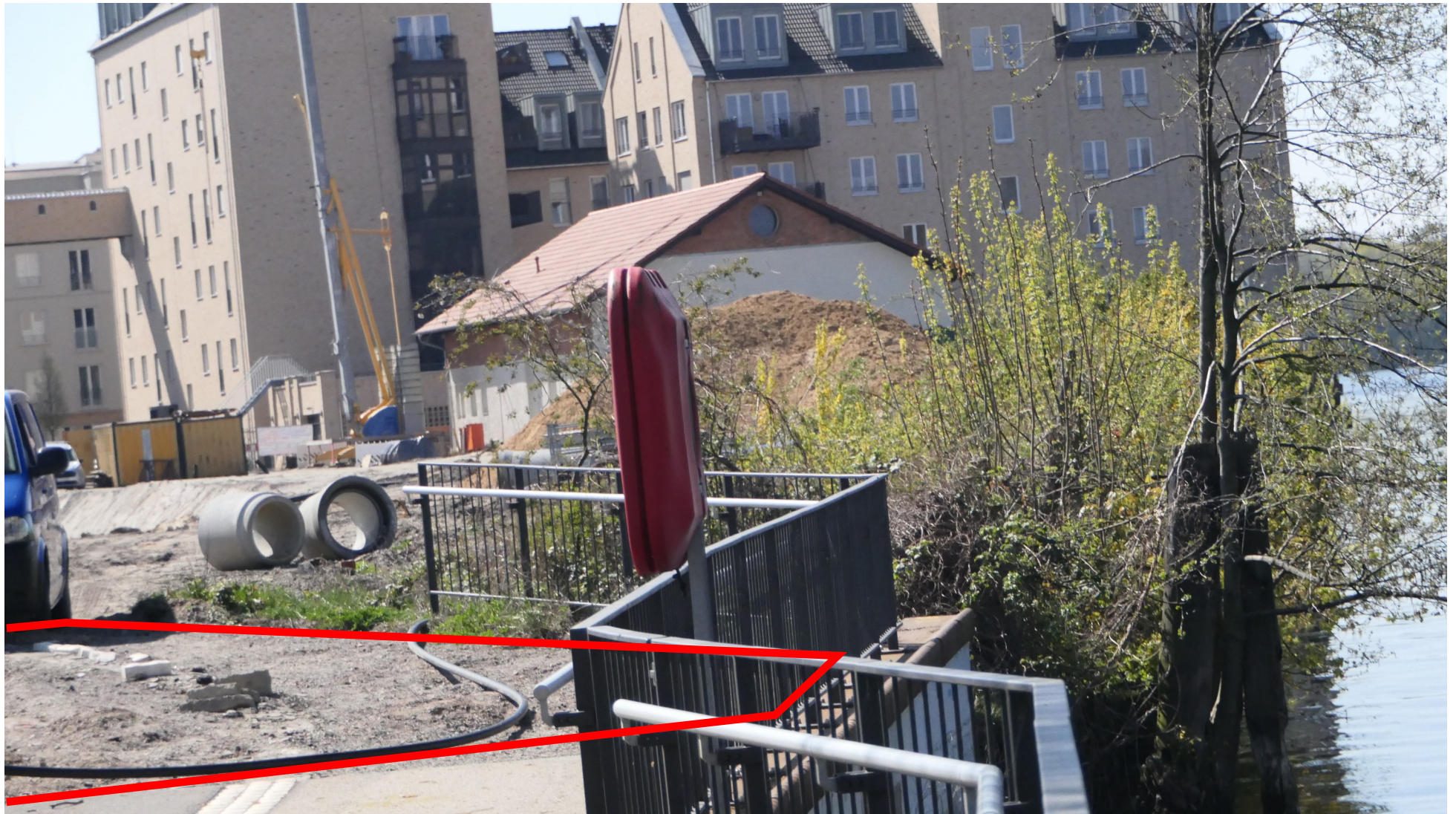
Aufnahme April 2019: Auch ein Teil des EU-geförderten Weges wurde abgerissen.
