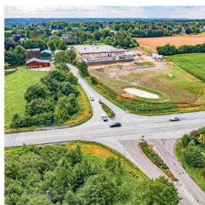
I krydset mellem Kreisstraße 90 og Landesstraße 96 ved Hyrup opstår tit farlige situationer.
